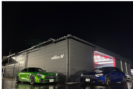
「調音施工スタジオ三郷」(office.M) 店舗外観
